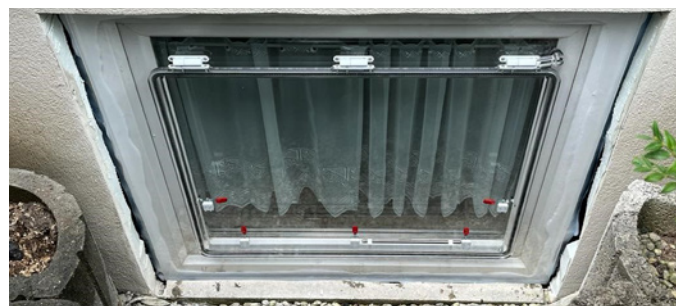
Windows Protector avec trappe basculante, vue de l'extérieur
