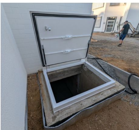
Trappe installée à l'horizontale pour protéger une sortie de secours / Trappe pour une installation dans un mur
