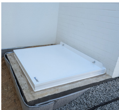
Trappe installée à l'horizontale pour protéger une sortie de secours / Trappe pour une installation dans un mur
