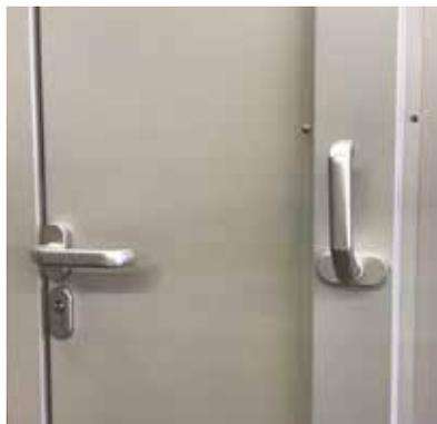
Poignée de porte et crémone pour l'activation du système AquaLOCK® placée au milieu du vantail
