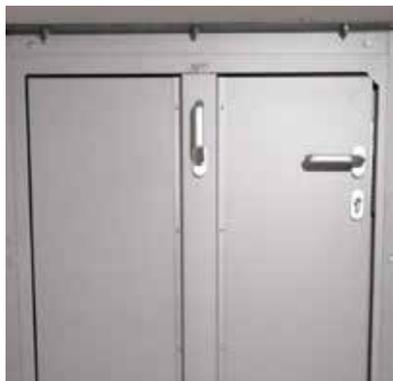
Porte d'entrée secondaire - résistance contre les inondations jusqu'à la hauteur de la poignée
